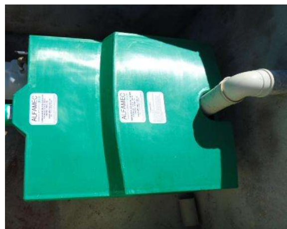
Equipamento de 2.000 L/h instalado (imagem com e sem a tampa)
